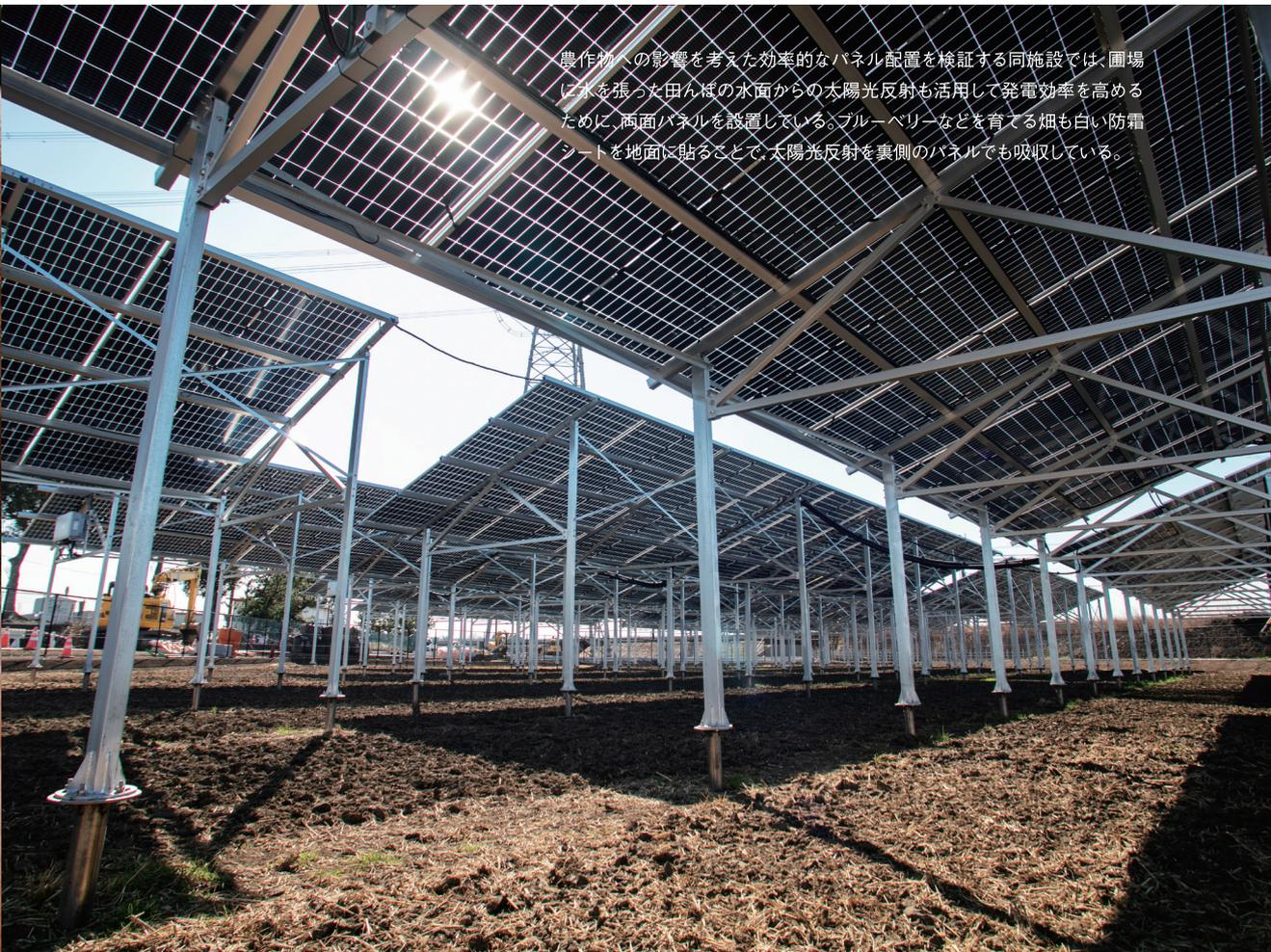
農作物への影響を考えた効率的なパネル配置を検証する同施設では、圃場に水を張った田んぼの水面からの太陽光反射も活用して発電効率を高めるために、両面パネルを設置している。ブルーベリーなどを育てる畑も白い防霜シートを地面に貼ることで、太陽光反射を裏側のパネルでも吸収している。
